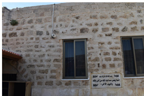
إعادة تركيب للجدار الحجريّ الذي هُدم | نظرة نحو الشمال من الفناء الداخلي نحو جدارٍ حجريّ في المسجد، تصوير ذاتيّ، 2024
