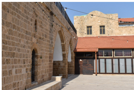
قصارة القناطر وإتلاف الحجر | نظرة من الفناء الداخلي نحو الرواق المقنطر الشماليّ، تصوير ذاتيّ، 2024
