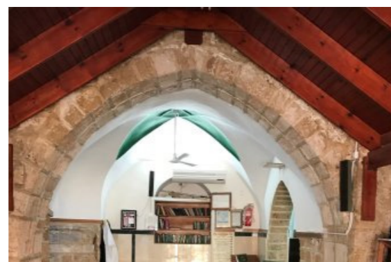
عرائش وبناء خفيف يُخفي سقف المبني | نظرة داخلية في الرواق المقنطر الجنوبيّ، تصوير ذاتيّ، 2024
