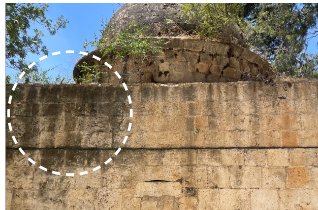
יוני, 2024. צילום: עדן גרה. בתמונות רואים שכבות העובש על האבנים וגם הצמחייה שרובן צומחת מסביב לכיפה ועל גג המקאם
