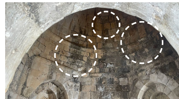
יוני, 2024. צילום: רגד ח'ורי. אפשר לראות התמונות למעלה את התיקונים מבטון ומלט שעשו אותם בחיבורים בין האבנים. תיקונים אלה אינם תקינים, הם מתפוררים עם הזמן ודווקא פוגעים באבן עצמו ובחיבורים ביניהם
