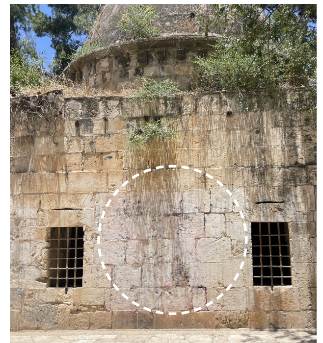
יוני, 2024. צילום: עדן גרה. בתמונות רואים את הסדקים מחוץ וגם בפנים למקאם. יש חלק מהסדקים שגם נראה משני הצדדים מה שמעיד על חומרתו
